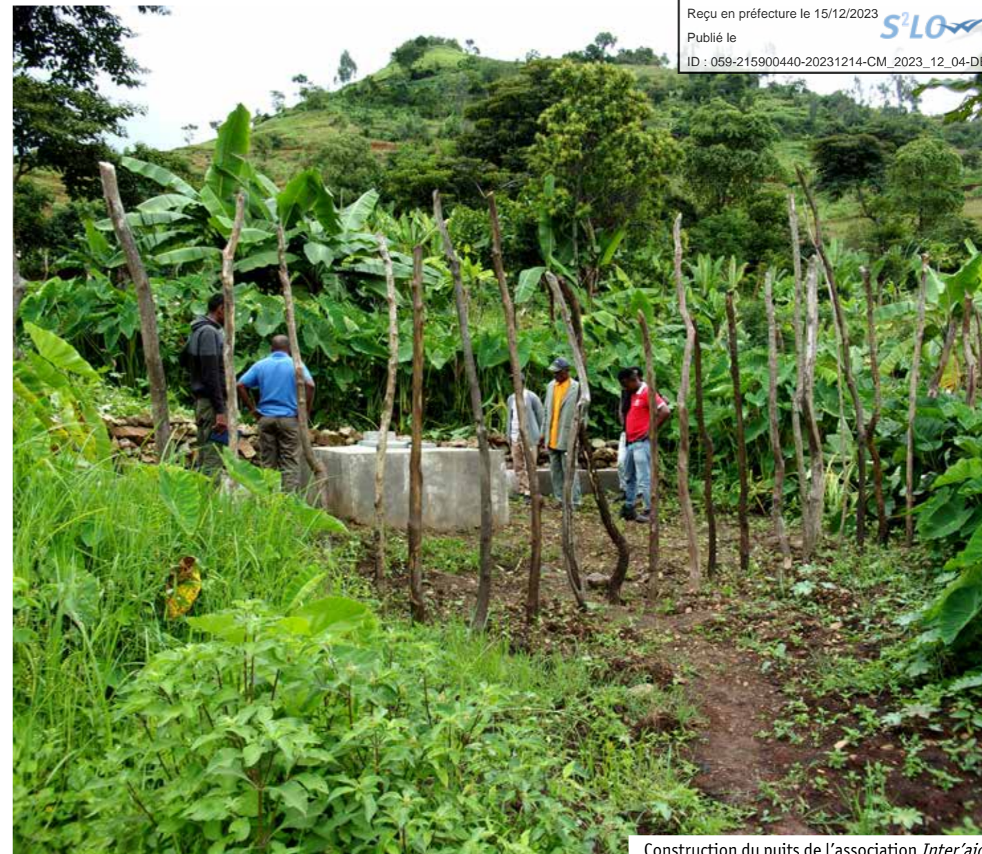
Construction du puits de l'association Inter'aide
