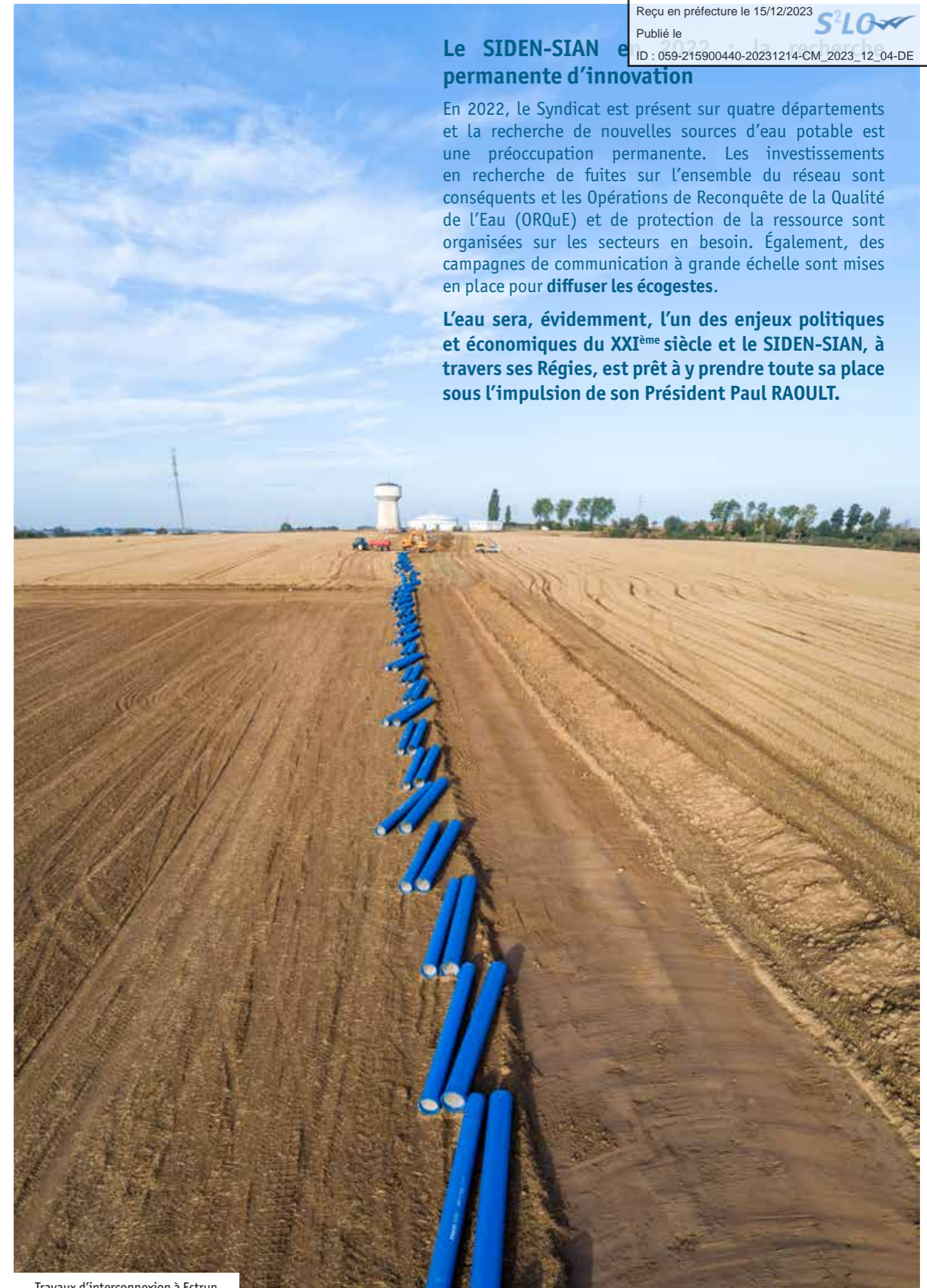
Travaux d'interconnexion à Estrun
