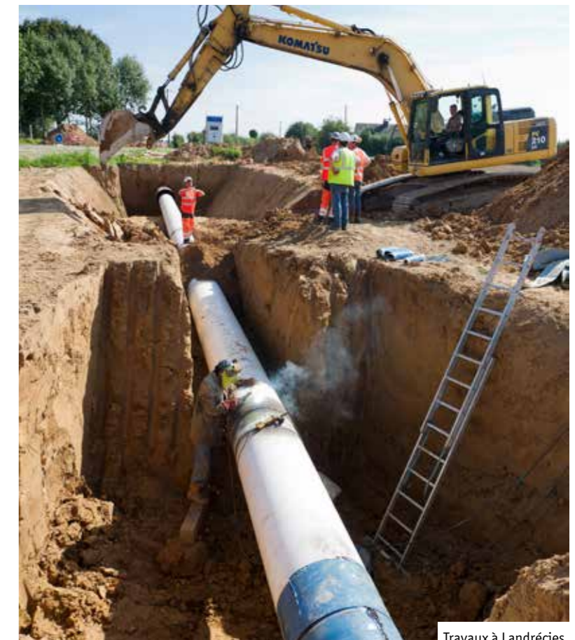
Travaux à Landrécies
