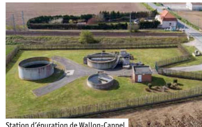
Station d'épuration de Wallon-Cappel
