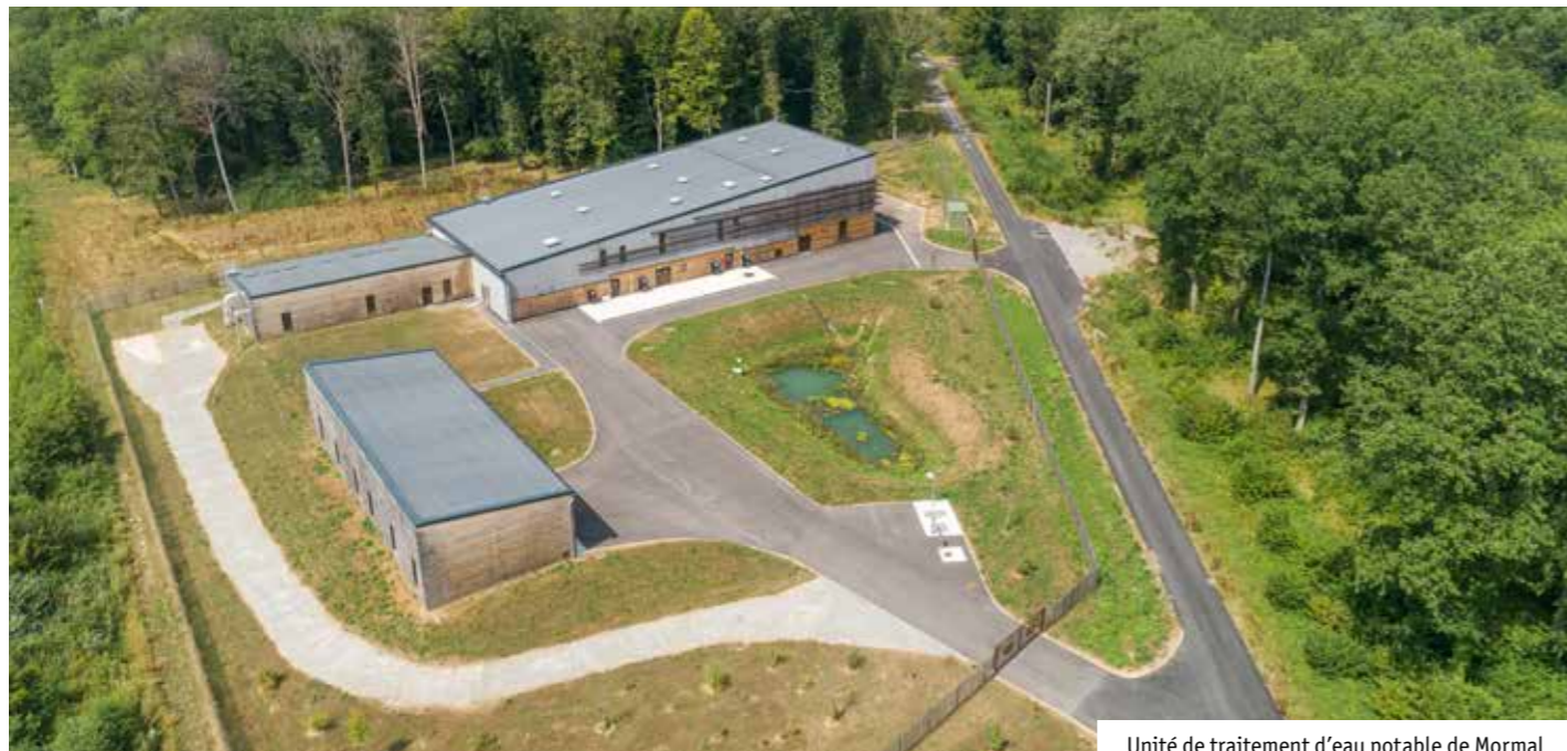
Unité de traitement d'eau potable de Mormal
